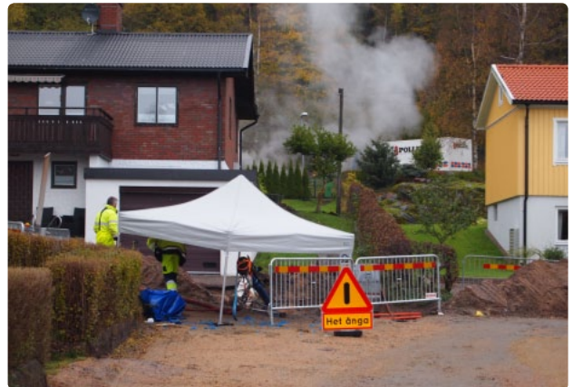
Geringe Umweltbeeinflussung durch grabenlose Verlegetechnik Little environmental impact by using trenchless technology
