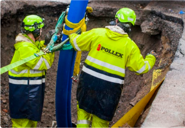
Rohreinzug über kleine Baugruben, geringer Platzbedarf für die Baustelle Pipe insertion in small pits, low space requirements on site
