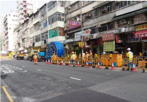
Der Verkehr kann weitestgehend ungehindert fließen. Traffic remains almost unobstructed.
