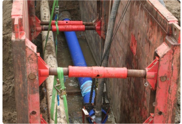
Kurze Sanierungszeiten und geringe Tiefbauarbeiten Short rehabilitation times and few excavation works
