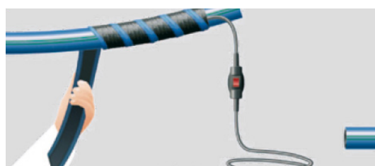
Afbeelding 2 : Wikkel de Pipe-Heater manchet te beginnen vanaf het uiteinde over de te tempereren buis.
