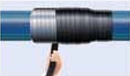
Pak het geheel in met Servi-wrap tape.
