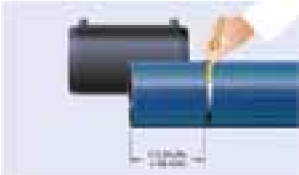
Markeer het af te schillen deel van de mantel (1/2 mof-hoogte + 30 mm).
